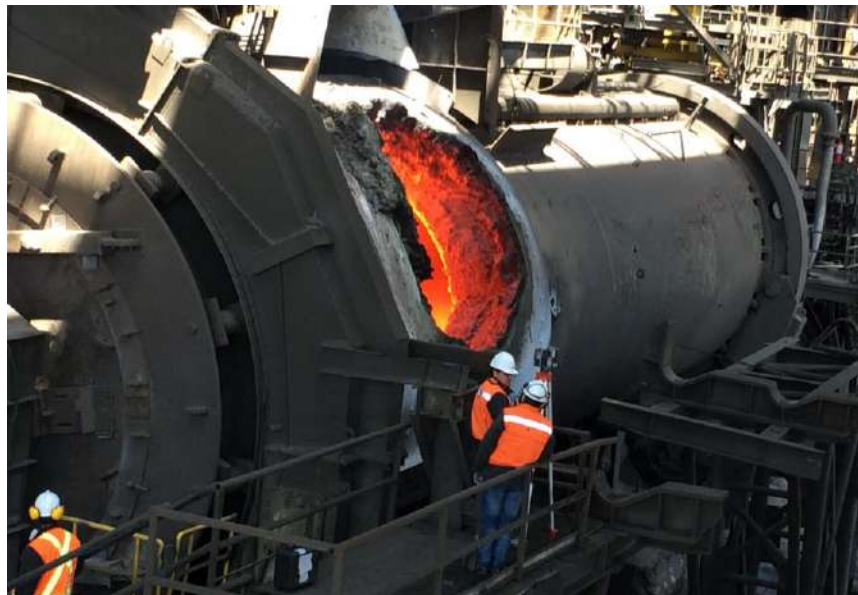
Figura 1: Reactor de Fundición Altonorte, Xstrata Copper.
