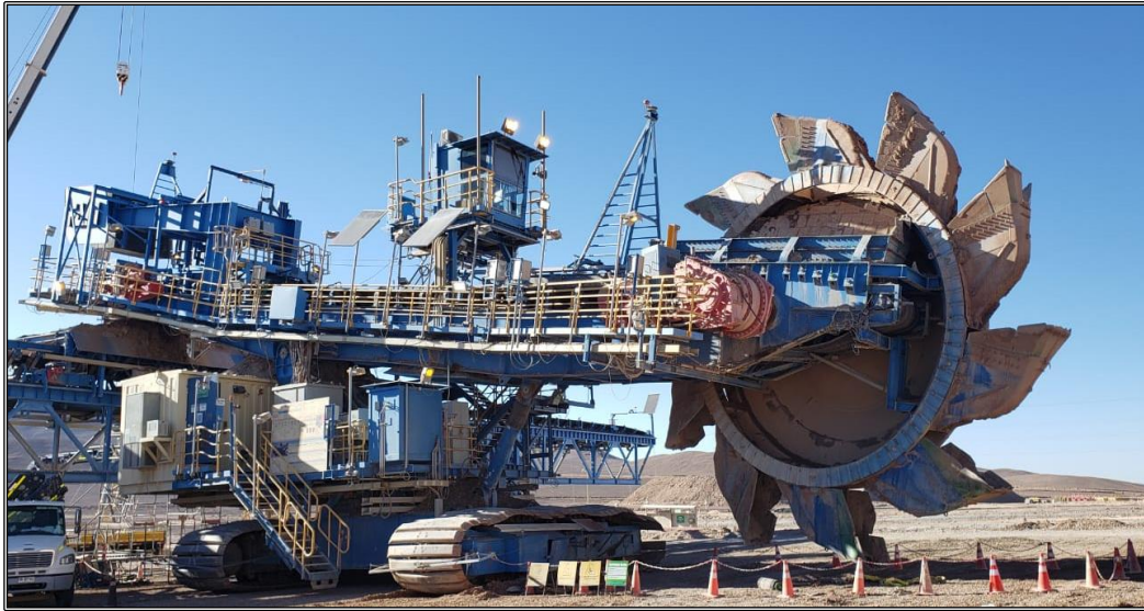
Figura N° 14: Inspección visual en terreno de Rotopala.
