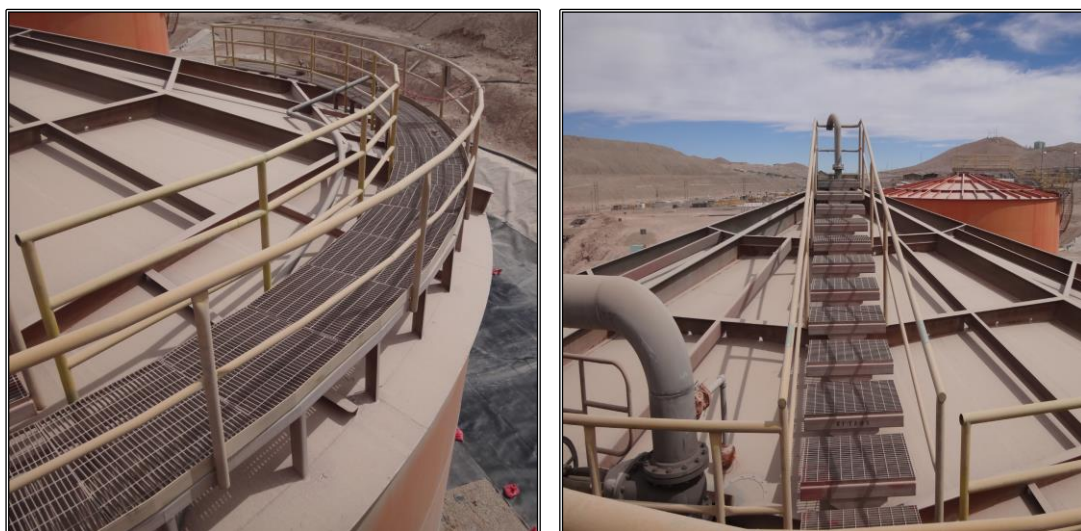
Figura N° 6: Vista del techo TK-2
