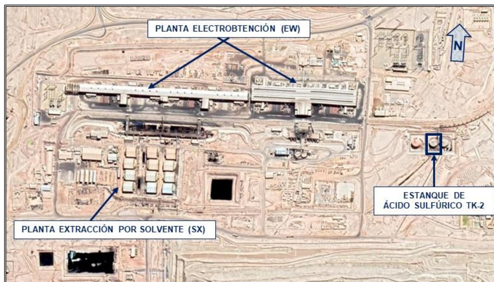
Figura N° 1: Ubicación del estanque de ácido TK-2, Planta SX Óxidos.
