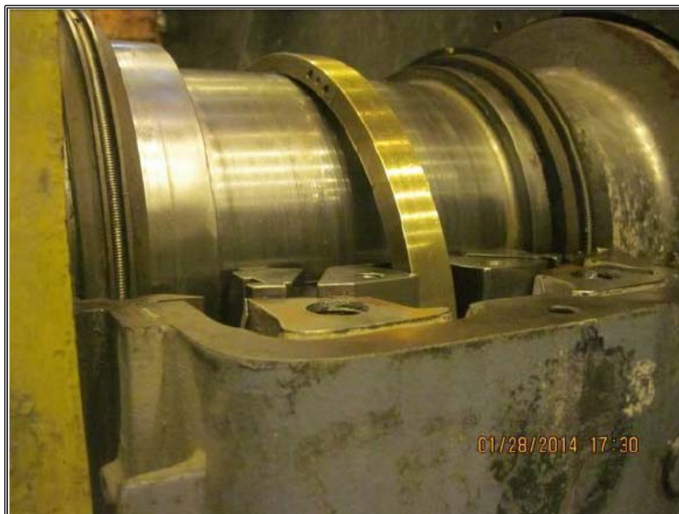
Figura N° 13: Febrero 2014. Deslizamiento de babbit de descanso de motor lado libre del Molino SAG N° 1.
