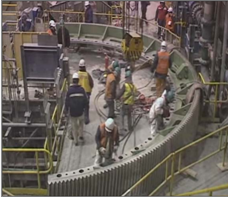
Figura N° 12: Cambio de corona Molino SAG N°1, año 2005
