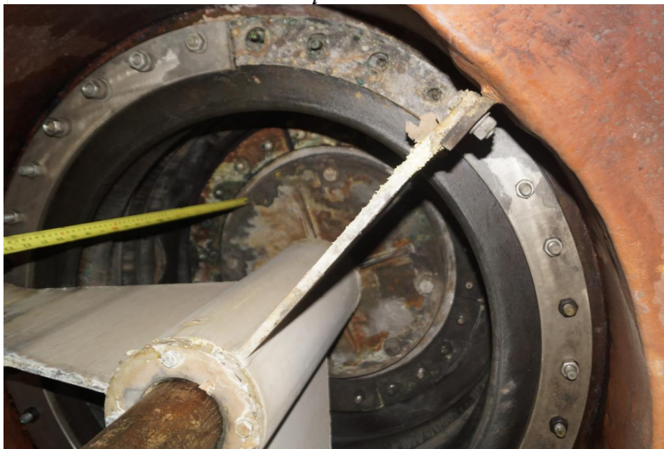
Figura 1: Anillo fuelle de flujo radial
