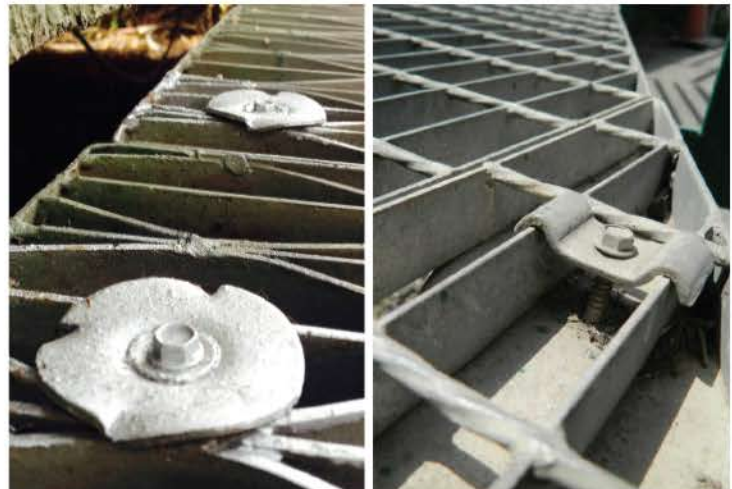
FIJACIÓN PARA LA INSTALACIÓN CON ARANDELA DE SUJECIÓN
