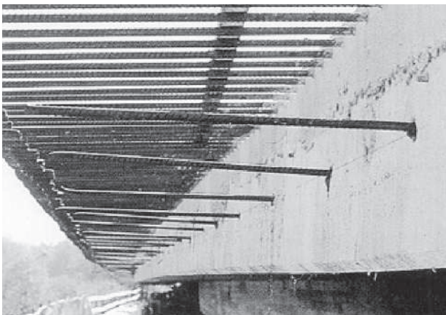
Refuerzo post instalado para diafragmas en un puente
