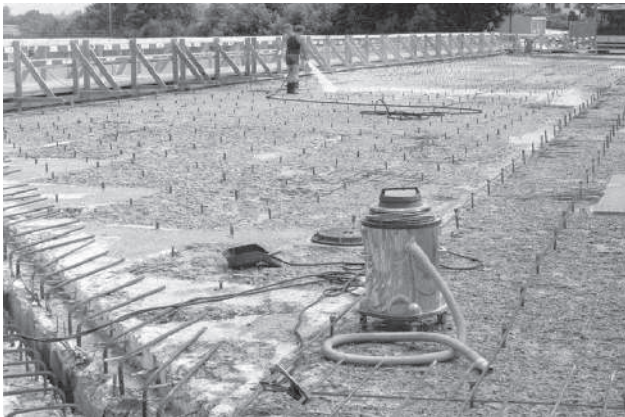
Barbas colocadas para la preparación de una nueva losa estructural
